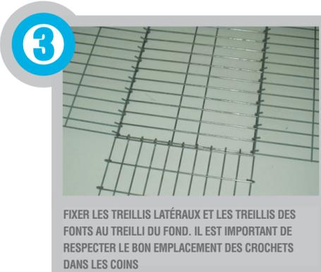
FIXER LES TREILLIS LATÉRAUX ET LES TREILLIS DES FONTS AU TREILLI DU FOND. IL EST IMPORTANT DE RESPECTER LE BON EMPLACEMENT DES CROCHETS DANS LES COINS
